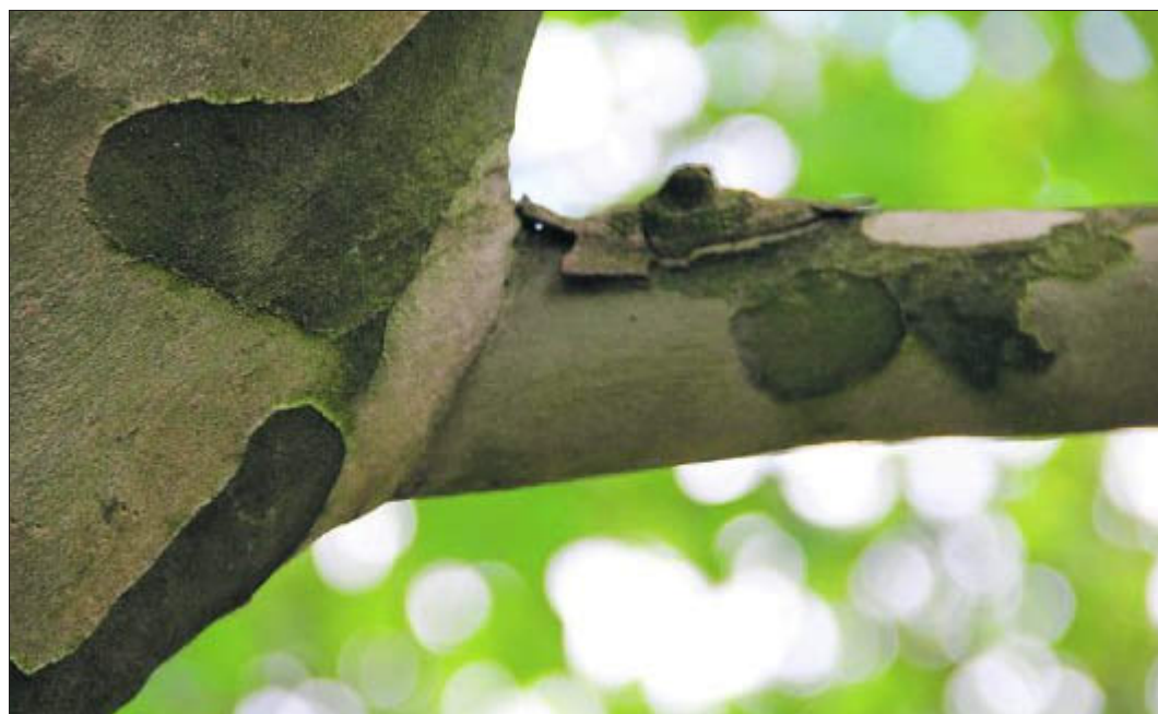
Massaria-Anfangsstadium: Der Astkragen ist verdickt, die Rinde blättert ab, an der Astspitze sind einige Feinäste abgestorben. Ein akuter Handlungsbedarf ist aber nicht gegeben.
